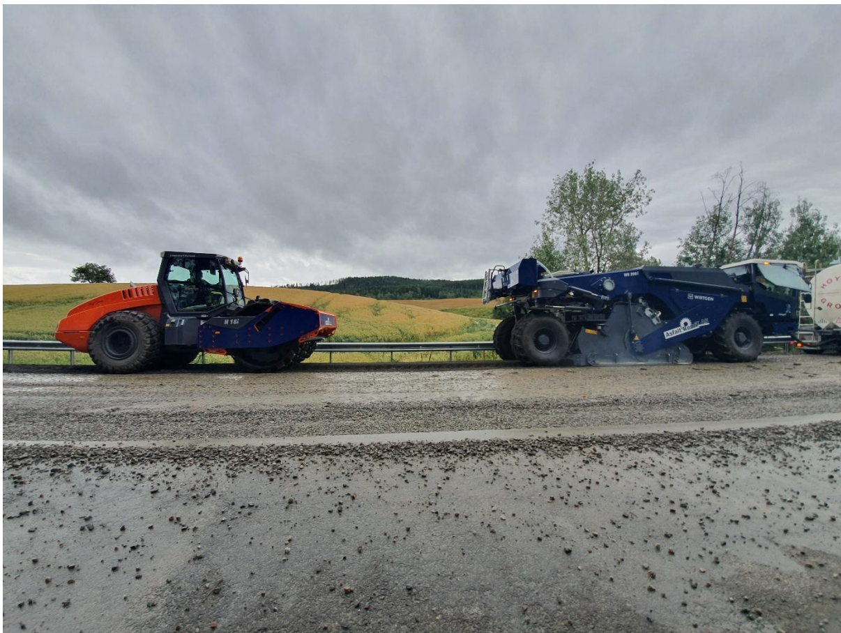
Bilde 11.4. Fresestabilisering av bærelag på lavtrafikkert vei
