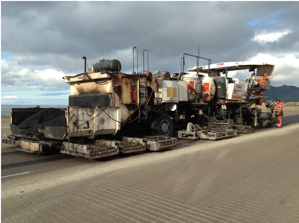
Bilde 11.2 Remixer i produksjon på rullebane/ flyplass
