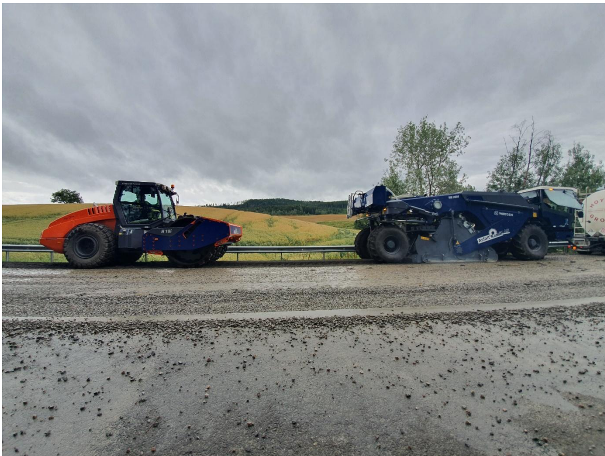
Bilde 11.4. Fresestabilisering av bærelag på lavtrafikkert vei
