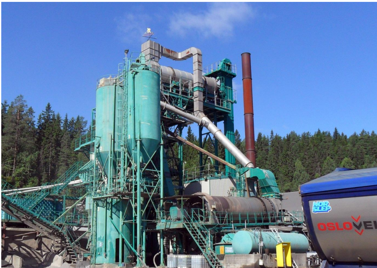
Bilde 9.3 Asfaltfabrikk med egen gjenbrukstrommel
