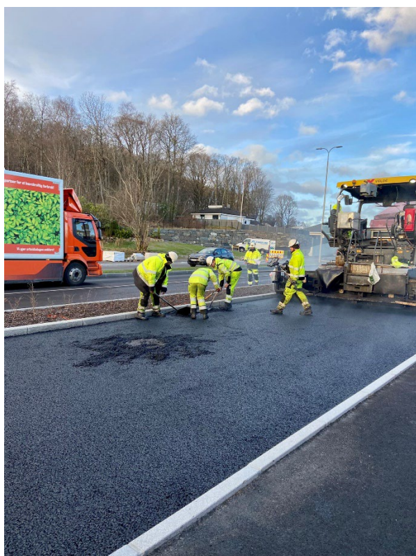
Bilder fra utlegging av Ska 11 med 40 % RA, 23. november 2022
