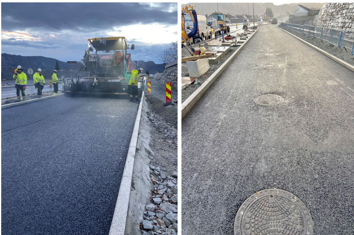
Bilder fra utlegging av Ska 11 med 60 % RA, 24. november 2022
