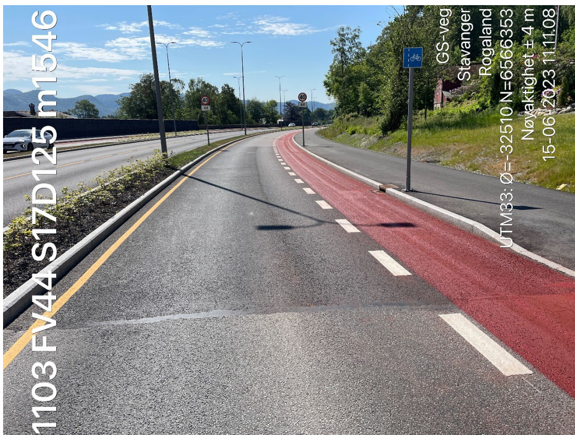
Bilde av reasfaltering av et område etter vannskade, tatt ved befarig 15.06.2023
