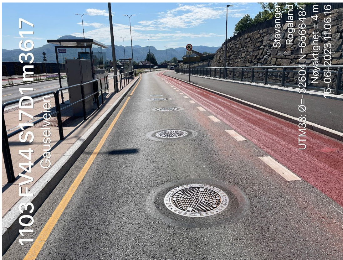
Bilde av utført reparasjon rundt kommer, tatt ved befarig 15.06.2023
