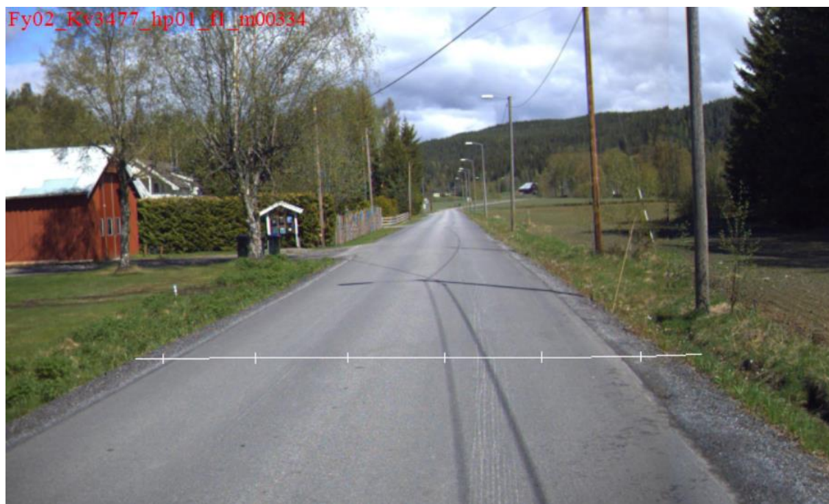
Grus-parsell er forsterket og asfaltert, spor etter veghøvel
