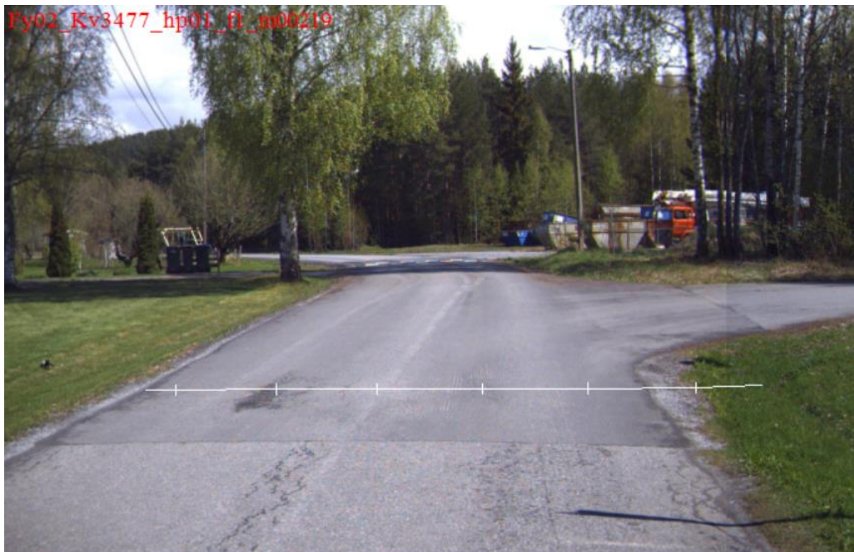
Grus-parsell er forsterket og asfaltert, bildet viser tidligere overgang grus – asfalt ved pel 220
