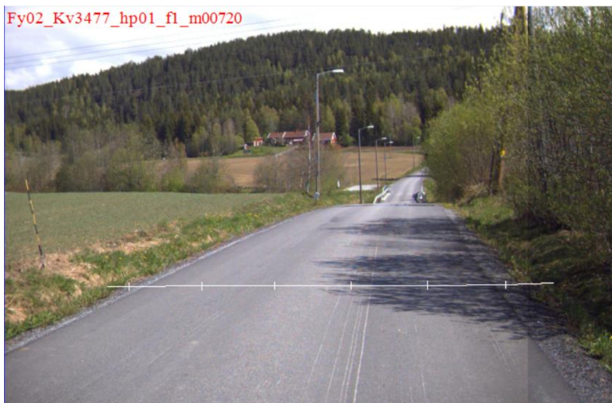
Grus-parsell er forsterket og asfaltert, spor etter veghøvel
