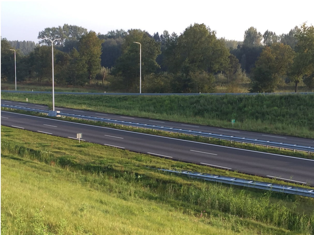
Bilde 3: Forsøksfelt (600 m 2 ) med dobbelt drensasfaltdekke på motorvei – LTA med 93 % gjenbruk.
